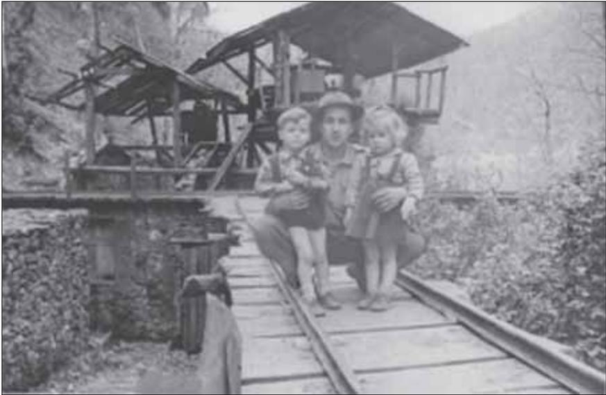
Fig. 1 - Immagine della stazioni della teleferica a vagoncini della Canale della Radice dalle gallerie minerarie alla prima tramoggia di carico durante il periodo di attività.
