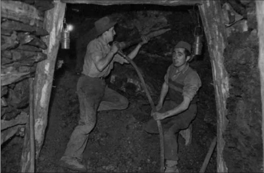
Fig. 5 - Attività dei minatori a Calcaferro nel periodo successivo alla guerra con visibilità dei "Castelli" di armatura delle gallerie in legname di castagno.
