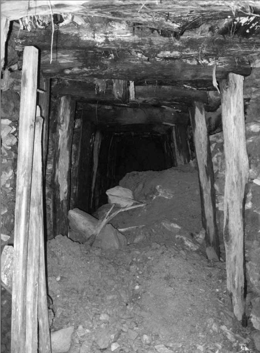
Fig. 9 - Ingresso e stato attuale di una delle miniere nella parte centrale dell'area mineraria di Calcaferro. Sono ancora visibili le armature in legno.
